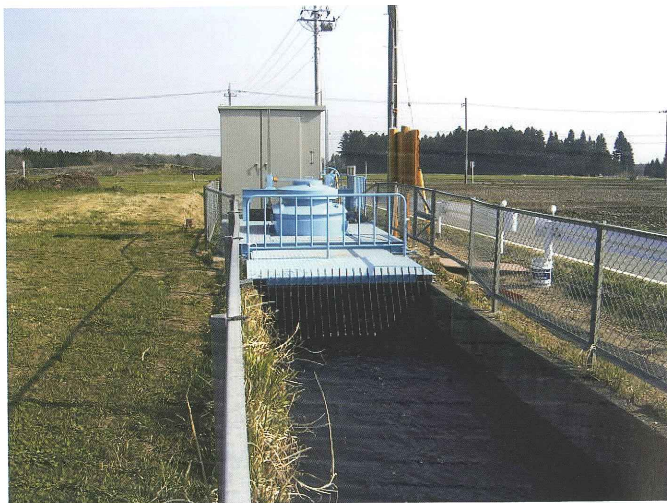
百村発電所全景
