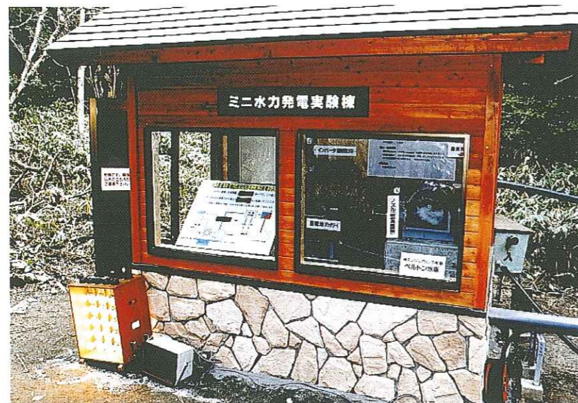
図2 (社) 日本山岳会上高地山岳研究所の発電小屋(出力:1kW)
