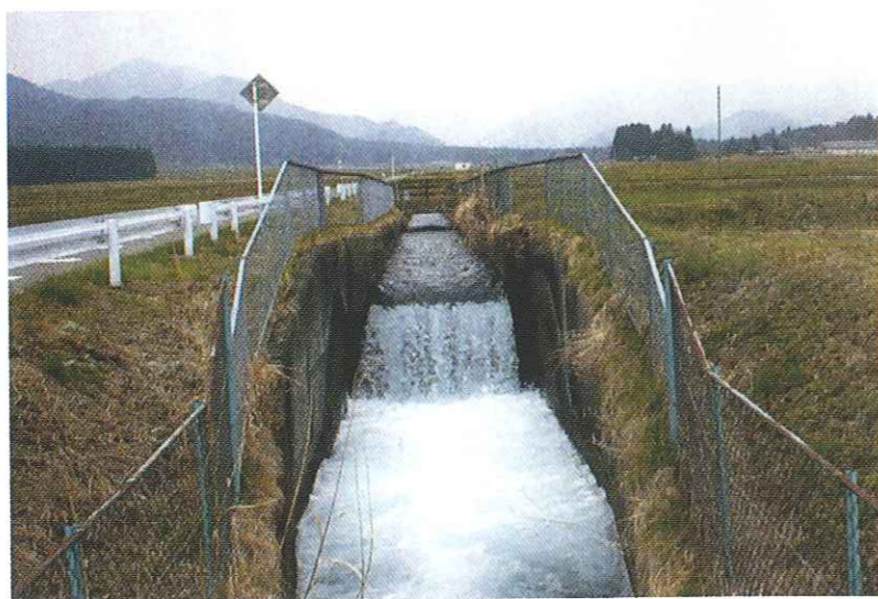
設置前の上段幹線用水路
