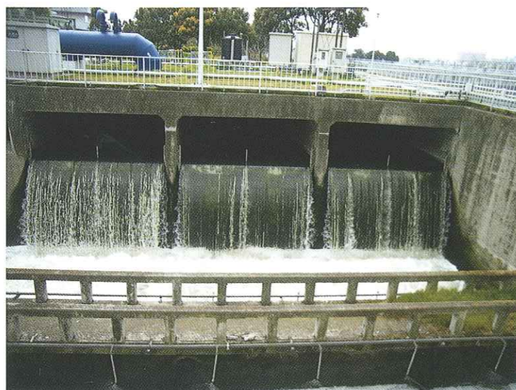
後付け工事でサイフォン（青い管）による取水
