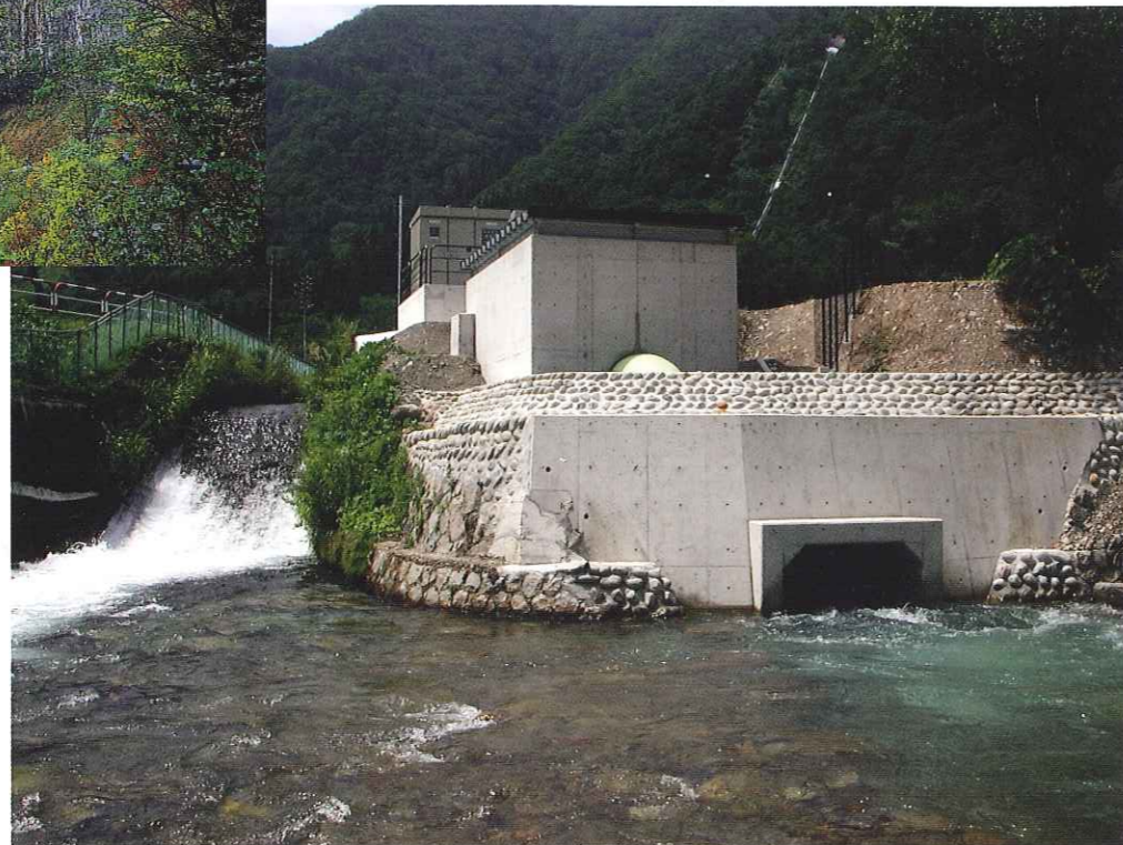
白川村小水力発電所（放流口側から撮影）
