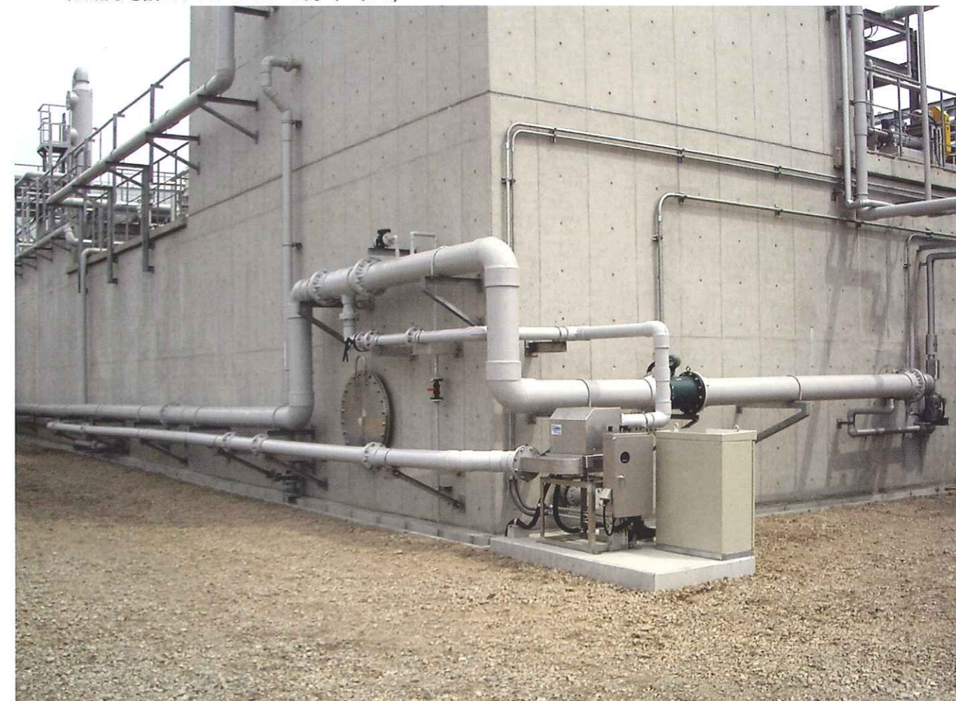
内蔵発電機とクロスフロー式水車 (CG)
