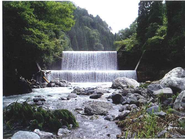
取水口を設置した砂防堰堤
