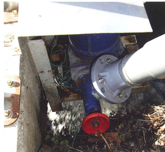
写真2: ベトナム製「パワーパル」(ターゴ) を農業排水路に設置
