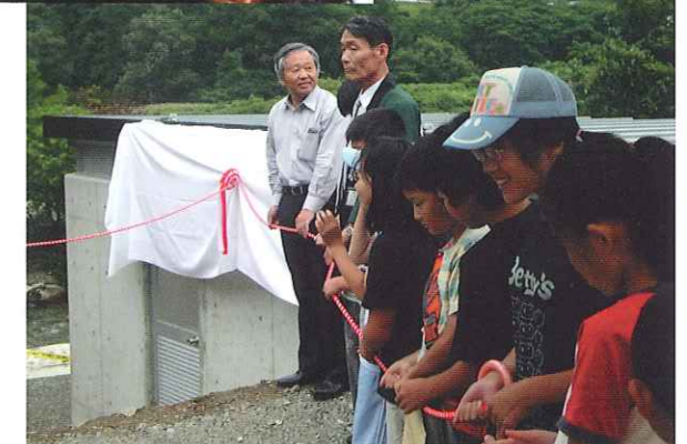
竣工式の代わりに、小学生を招いて完成記念見学会を実施
