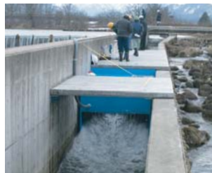
東北地方整備局 秋田県雄物川（一級河川） 大久保堰 呼び水水路
