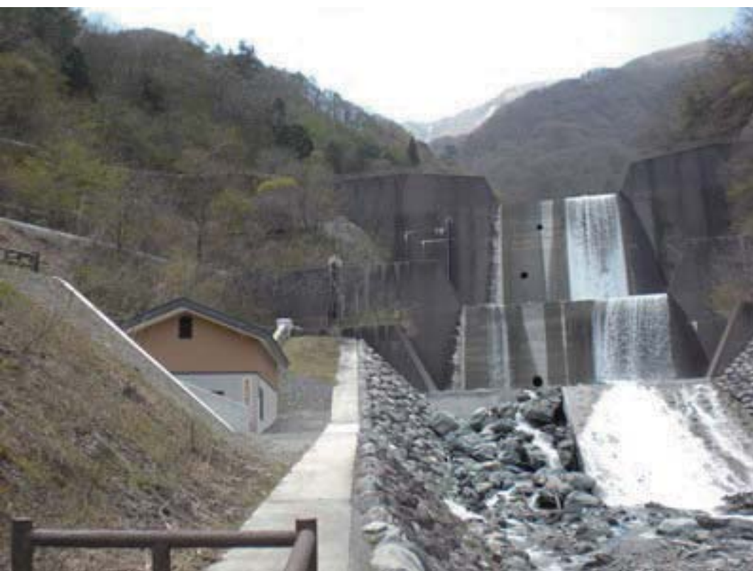
【写真1】金山沢川水力発電所の全景 左に見える小屋が発電所建屋。右側に見えるのが砂防堰堤である。上段より取水している。
