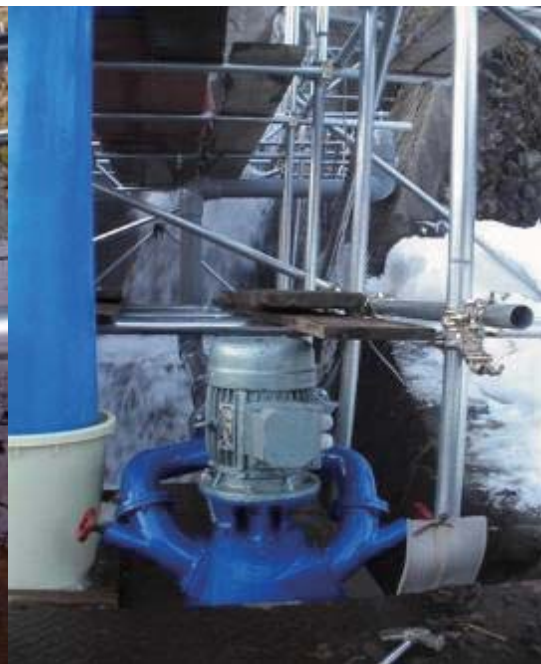
【写真4】ターゴ型 (パワーパル・1.0kW)
