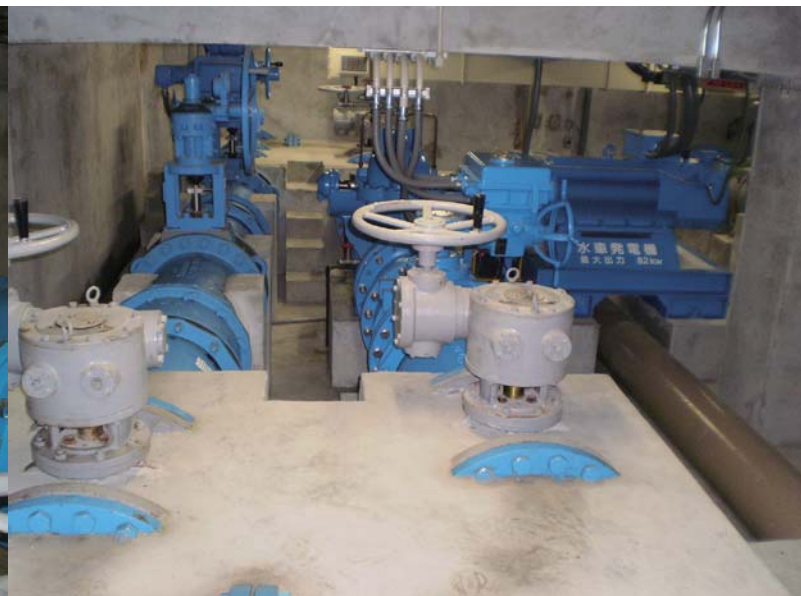
【写真2】 設置されている導水管
