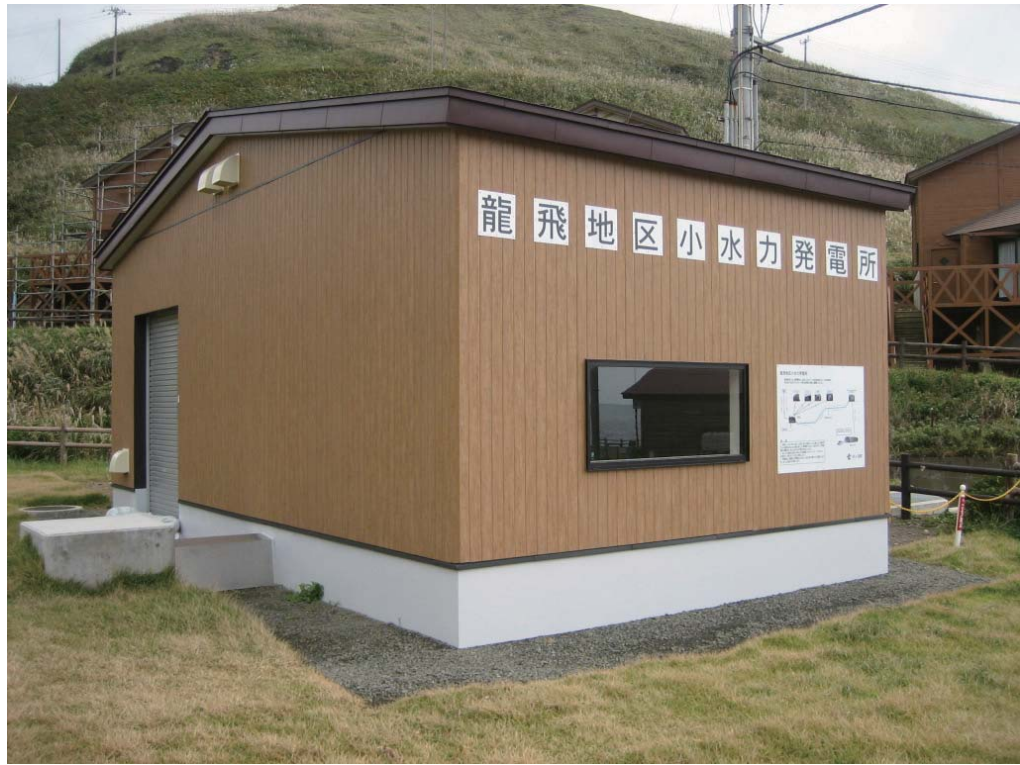
【写真2】 発電所建屋
