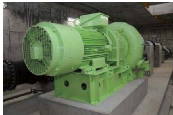
【写真1】 水車と発電機
