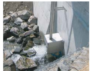
四国地方整備局 徳島県吉野川（一級河川） 切戸樋門
