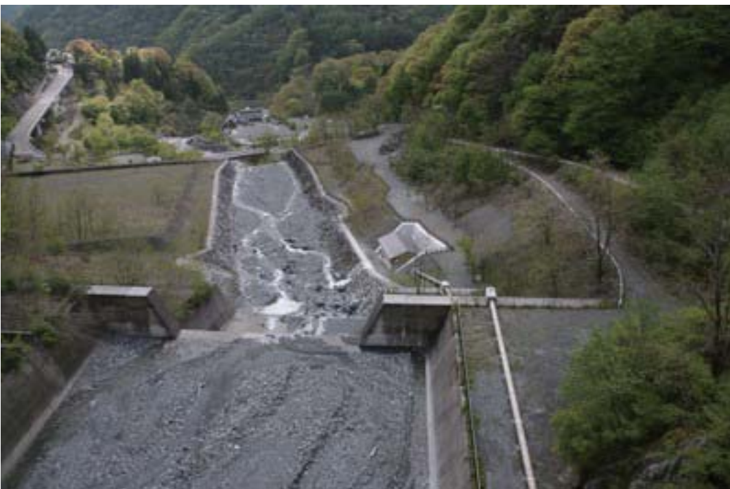
【写真2】 発電所を上段の堰堤から眺めた写真 手前から建屋に向かっているの水圧管である。
