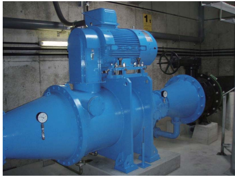
【写真1】 水車と発電機
