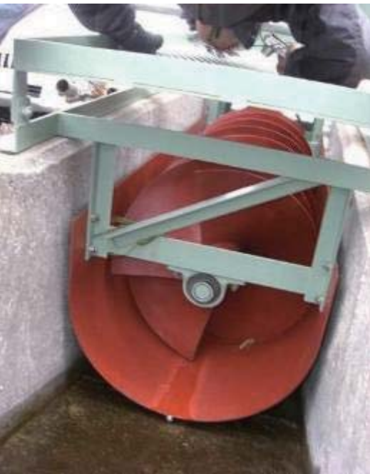
【写真2】らせん型1号機 (篠田製作所・0.5kW)
