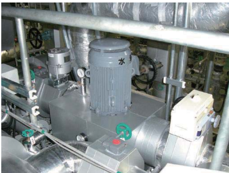
【写真2】福岡放送局の水車と発電機
