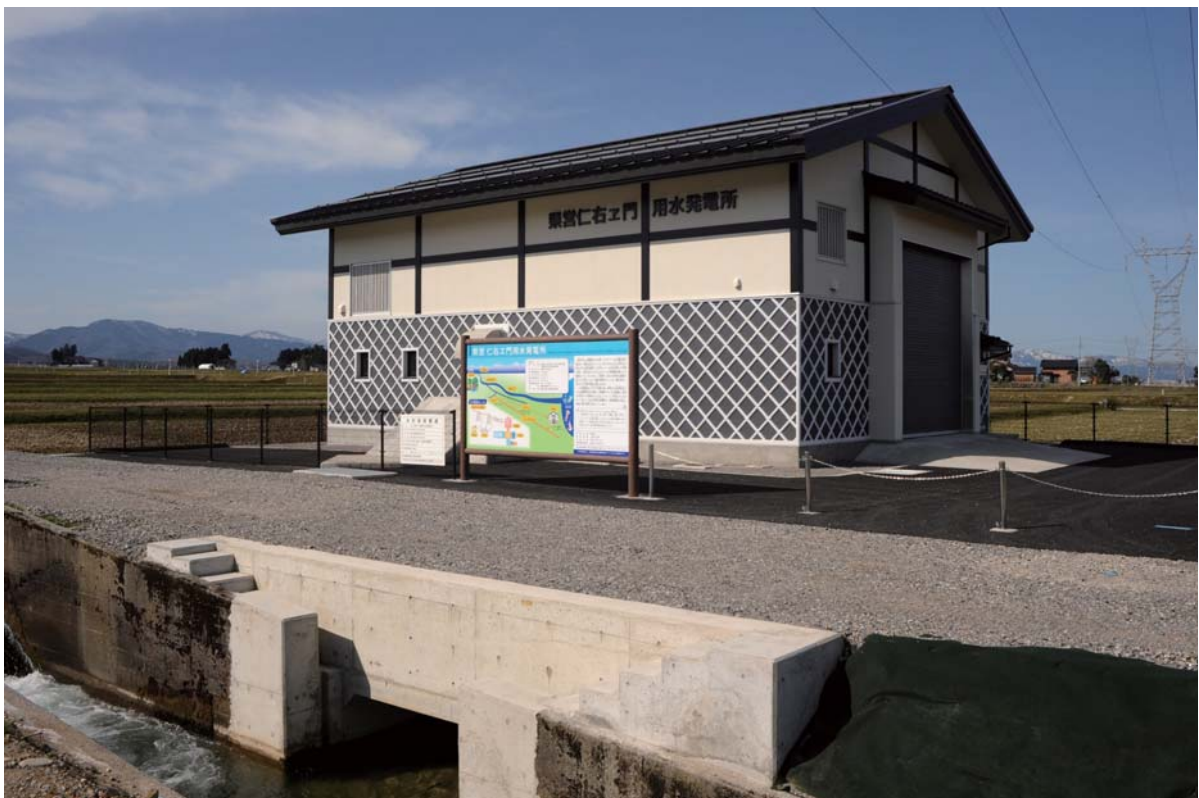
【写真3】 発電所建屋別角度 手前に見えるのが放水口。
