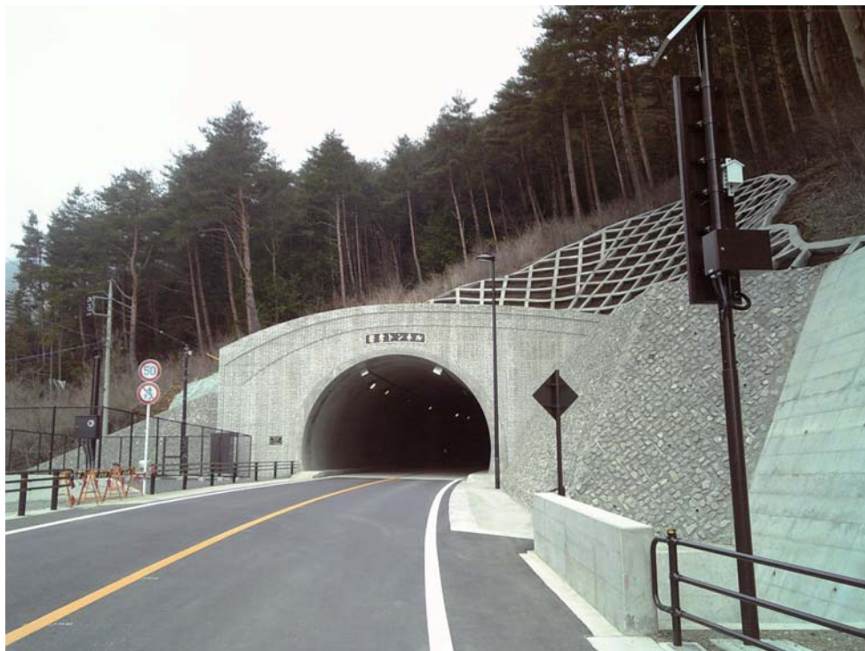
【写真2】 若彦トンネル
