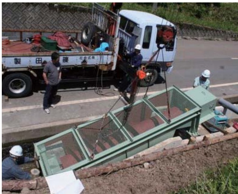
【写真5】らせん型2号機 設置の様子
