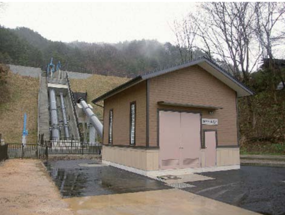
【写真2】 町川水力発電所建屋。 奥に見えるのが水圧管。
