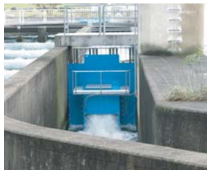
中国地方整備局 鳥取県日野川（一級河川） 日野川堰 呼び水水路
