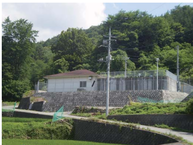
【写真3】 須玉第一減圧槽全景
