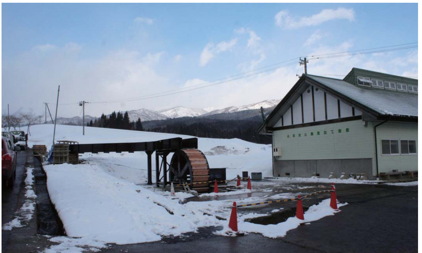
【写真10】上掛け水車全景（左に見える水路より取水）
